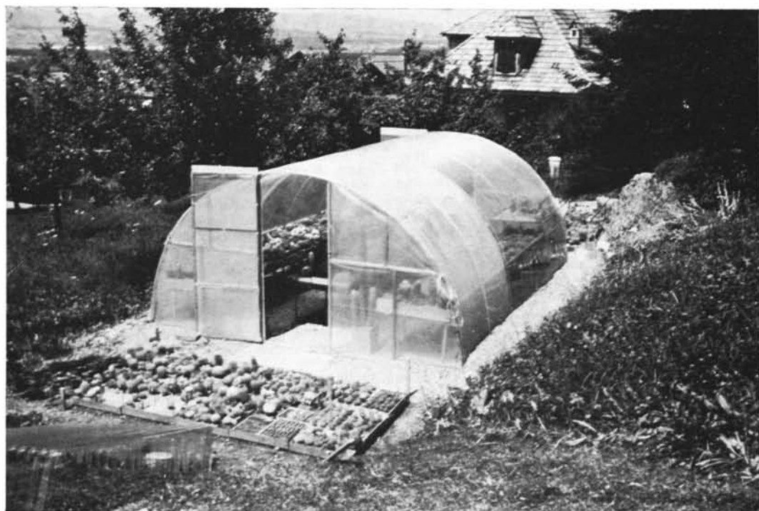
Das aus PVC-Wellplatten gebaute Gewächshaus des Verfassers. – Abbildung aus dem Archiv der DKG-Ortsgruppe Freiburg. Foto: Dieter Hönig.
